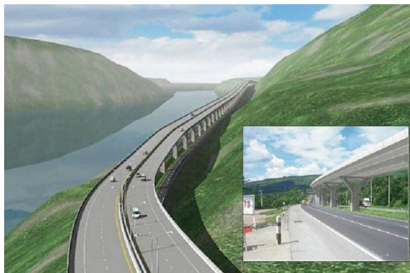
ภาพที่ 2 โครงการทางหลวงพิเศษระหว่างเมืองหมายเลข 6 สายบางปะอิน-นครราชสีมา ที่มา : Department of Highways (2018)
